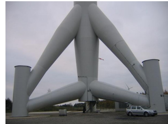
Onshore-Fundament (oben ) Tripod einer Offshore-WEA (unten)
