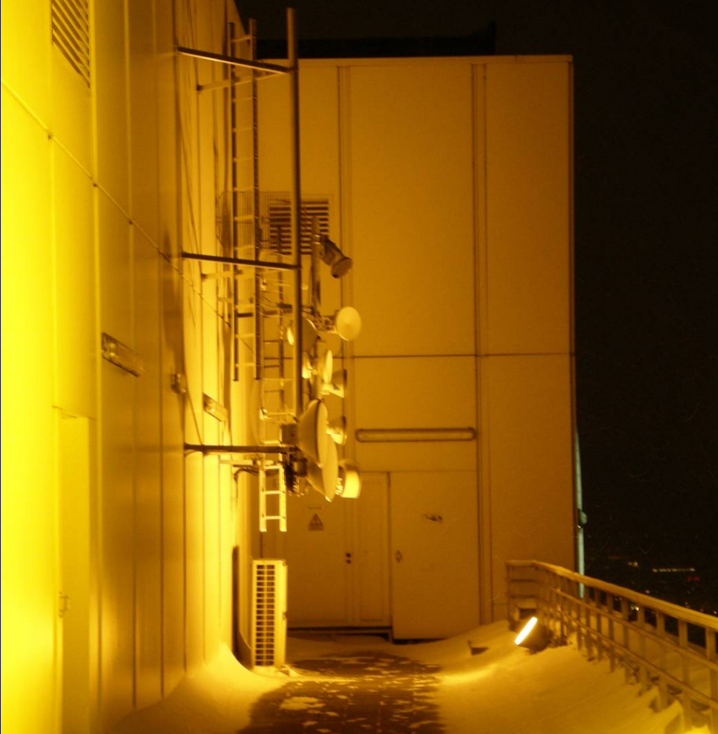
Ostseite/ nördliche Antennenhalterung
